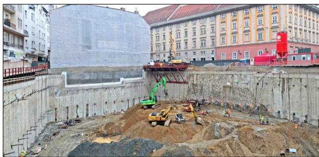
1. ábra: Szervita téri munkagödör kivitelezés közben
